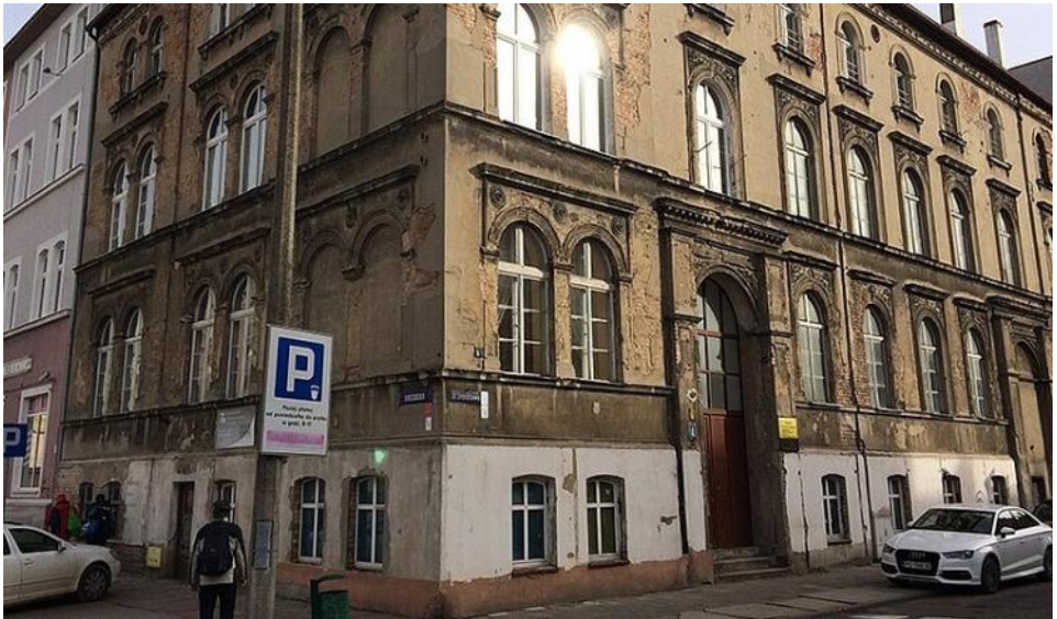
Gebäude vor der Sanierung
